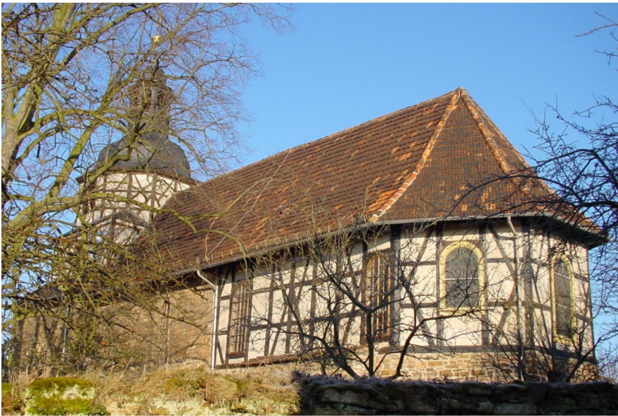
Kirchenansicht von Südosten
