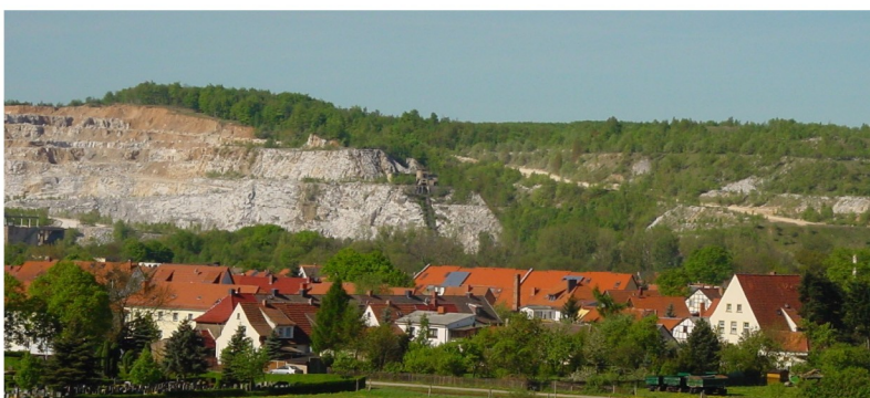
Ortsansicht von Nordosten
