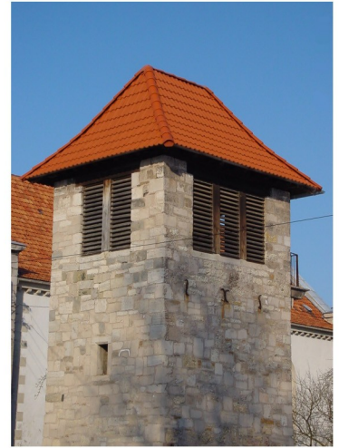
Frei stehender Glockenturm
