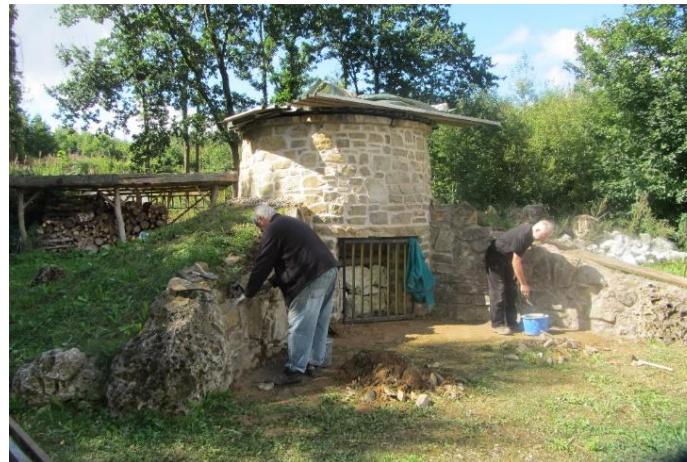
Feinarbeiten an der Einfassung
